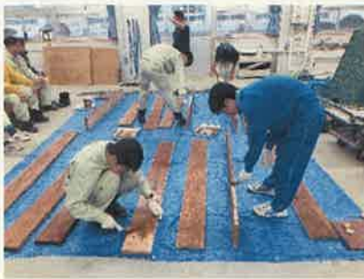
図-1 床板の防腐剤塗布状況
