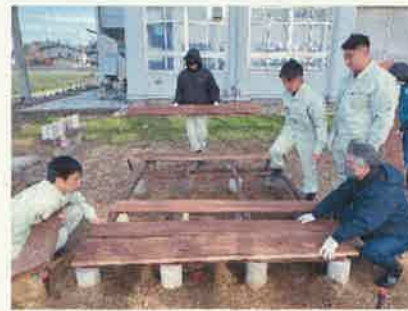
図-2 床板の取り付け状況
