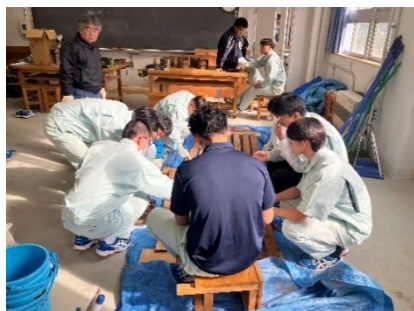
図-1 床板の防腐剤塗布状況
